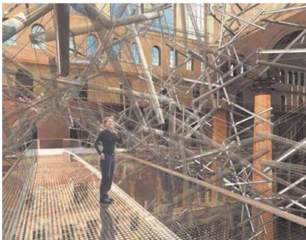
Slika 12 – Pješačka pasarela O. Arupa u Washington muzeju: složena tensegrity struktura – umjetničko djelo.
