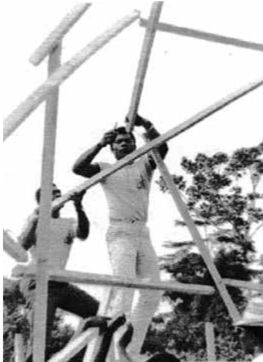
Slika 3 – Sferna tensegrity konstrukcija: vježbe studenata druge godine BT odjela Arhitektonskog fakulteta KNUSTa pod mentorstvom Sam Spencera. Snimljen i S8 film-dokument.
