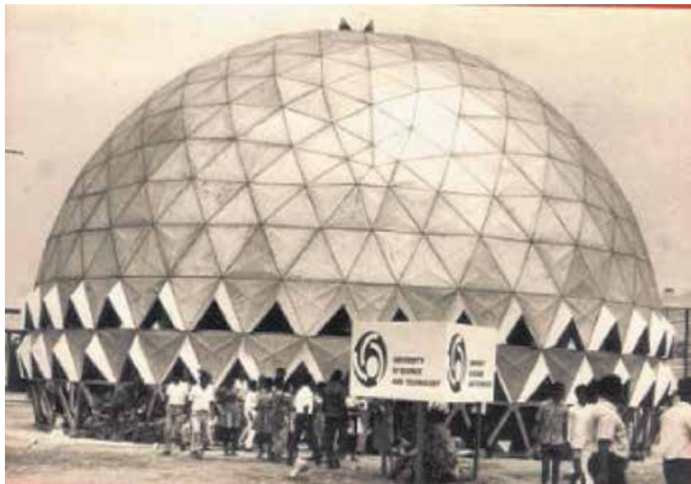
Slika 5 – Alumijska 19 m, 6F kupola izložbenog paviljona KNUST-a na prvom velesajmu Gane u Accri. Terenski rad i projekt studenata 1. godine Arhitektonskog fakulteta KNUST-a u Kumasiju (1976.). Inspiriran idejama B. Fullera, Sam Spencer, predavač na AF, organizirao je izvedbu kupole kao dokaz da se u TRI tjedna intenzivnog rada terenske nastave mogu savladati sva znanja i vještine, da se praktično iz „ničega“ izvede zapažena struktura. Aluminij i alat pribavio je ALCO GHANA.
